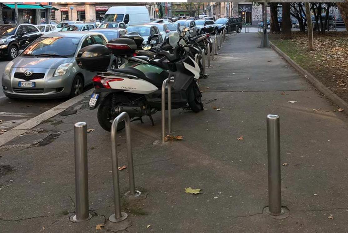
Sul lato est del giardino gli archetti di acciaio sono posizionati in modo disfunzionale, e la pavimentazione è particolarmente degradata. La sistemazione potrebbe includere anche un ampliamento dell'aiuola.
